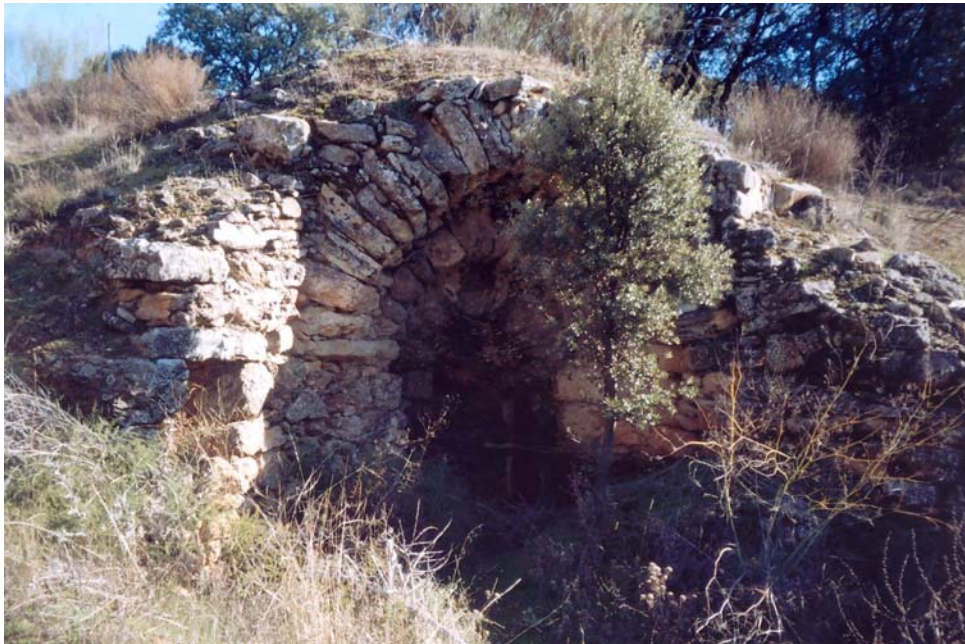
Figura 21: Entrada al horno en el que se aprovechaban las rocas carbonáticas del Cretácico superior para obtener cal.
